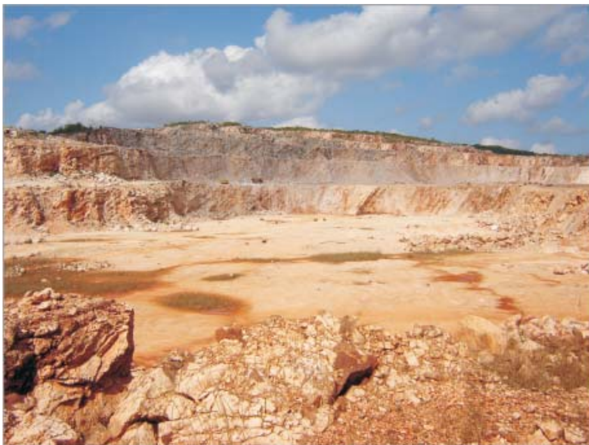
Fig. 10.5: Cantera de extracción de caliza para áridos (falda meridional de la Sierra de Cubitas, Camagüey).
