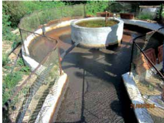
Biodigestor casero de cúpula fija tipo chino
